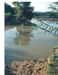
Brèche dans la digue à Aramon
