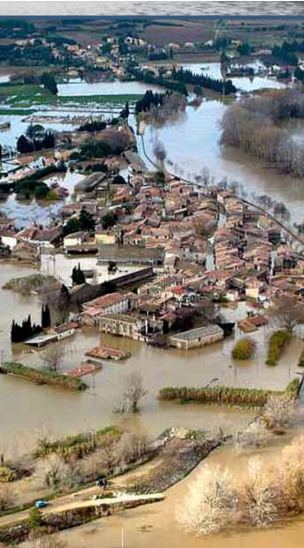
Le village de Comps lors de la crue du Gard en 2002
