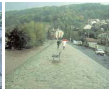
Digue à Brives-Charensac, Loire amont
