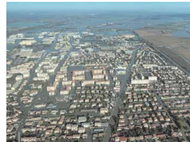
Arles sous l'eau, inondation 2003
